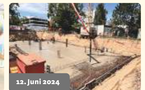
12. Juni 2024 Die Bodenplatte wird gegossen.
