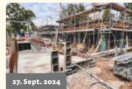
27. Sept. 2024 Die Tiefgaragen-Einfahrt wurde ausgegossen.
