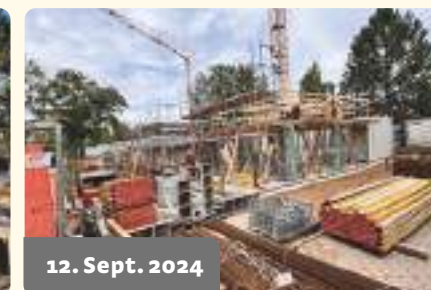
12. Sept. 2024 Das Erdgeschoss nimmt Form an.
