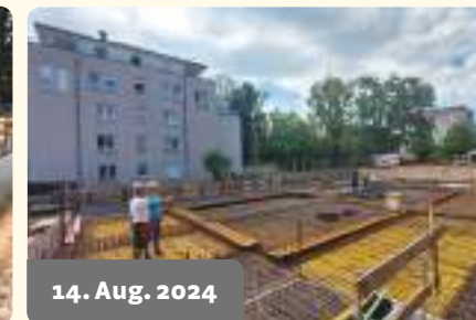
14. Aug. 2024 Das Stahlgeflecht der Tiefgaragendecke steht.
