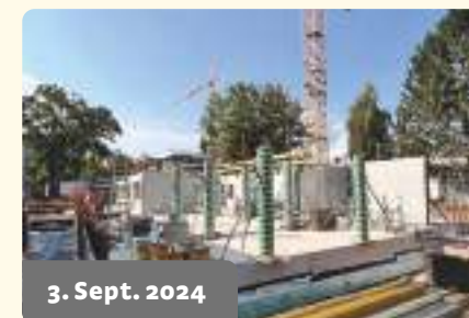
3. Sept. 2024 Wände & Stützelemente im EG sind gesetzt.
