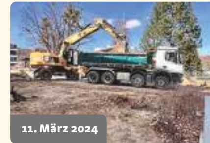
11. März 2024 Startschuss auf unserer Baustelle.
