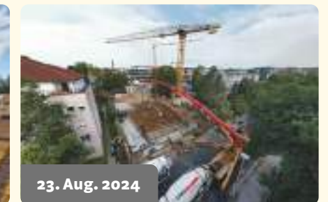
23. Aug. 2024 Betonausguss der Decke der Tiefgarage.
