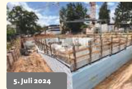
5. Juli 2024 Die Wände der Tiefgarage sind errichtet.
