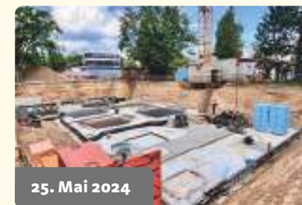
25. Mai 2024 Die Bodenplatte nimmt Gestalt an.
