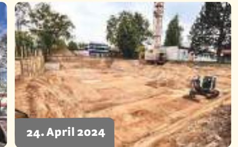
24. April 2024 Die Baugrube wird ausgehoben.
