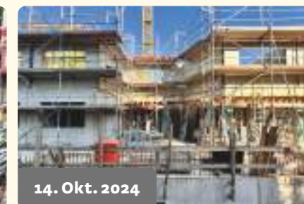
14. Okt. 2024 Das erste Obergeschoss wird gebaut.
