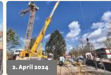
2. April 2024 Der Baukran wird erfolgreich aufgestellt.
